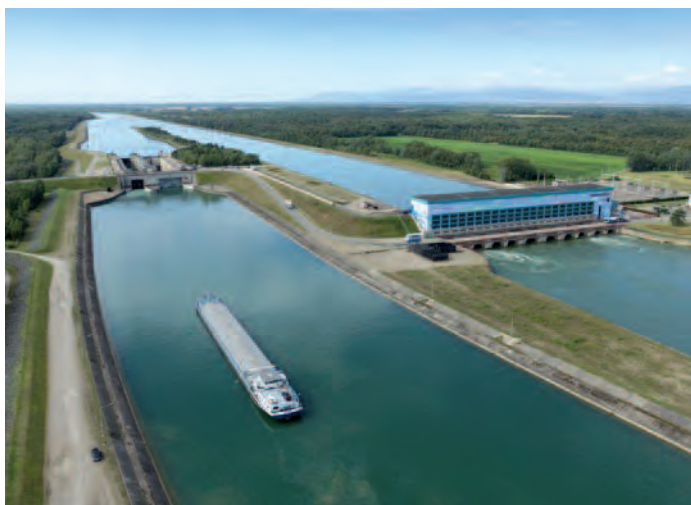
La centrale à écluses de Marckolsheim, sur une dérivation du Rhin.
